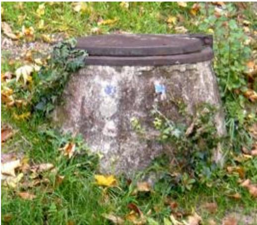
Das Leitungswasser kam bis 1929 nur aus 2 Quellfassungen (6-7 m tief) in Flur „In Ficklers Garten“. Tonrohre führten es zum etwa 40 Meter entfernten Hochbehälter hinab.
